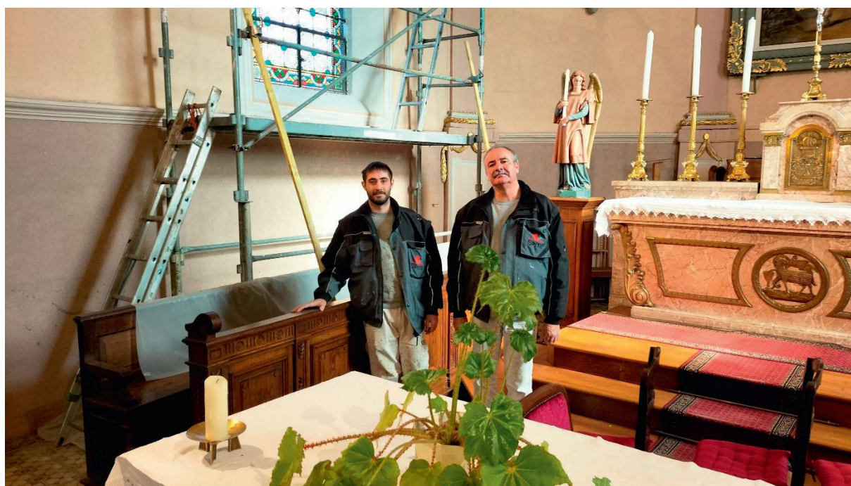
La hauteur sous plafond a nécessité la pose d'échafaudages par l'entreprise Spitz, père et fils.
